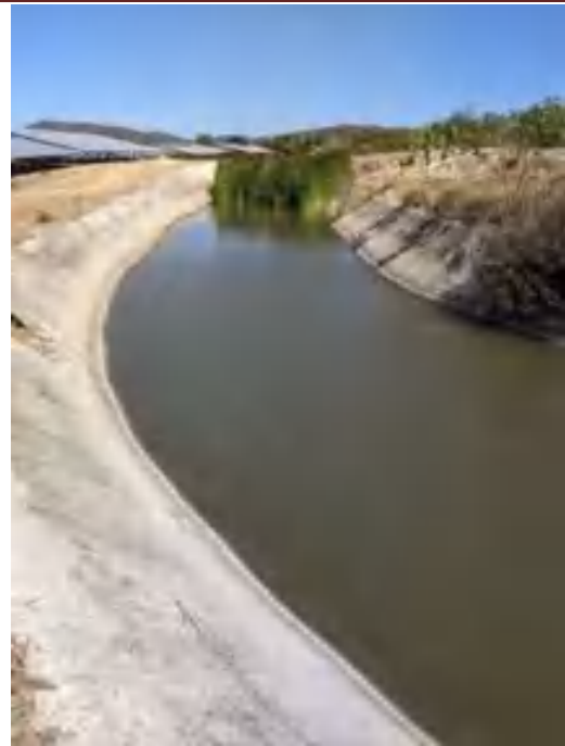
Hình 3.4. Rãnh thoát nước bằng bê tông tránh xói mòn móng trụ giá đỡ các tấm pin Hình 3.5. Kênh thoát nước mưa chính của Dự án
