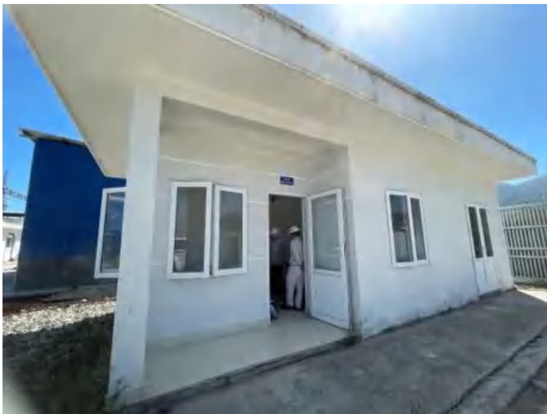
Hình 3.8. Kho chứa CTNH nhà máy điện mặt trời Nhị Hà
