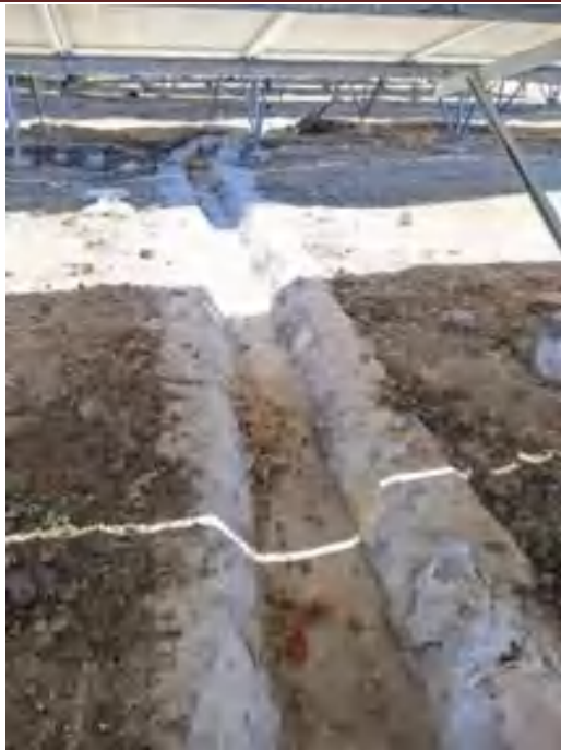
Hình 3.4. Rãnh thoát nước bằng bê tông tránh xói mòn móng trụ giá đỡ các tấm pin Hình 3.5. Kênh thoát nước mưa chính của Dự án
