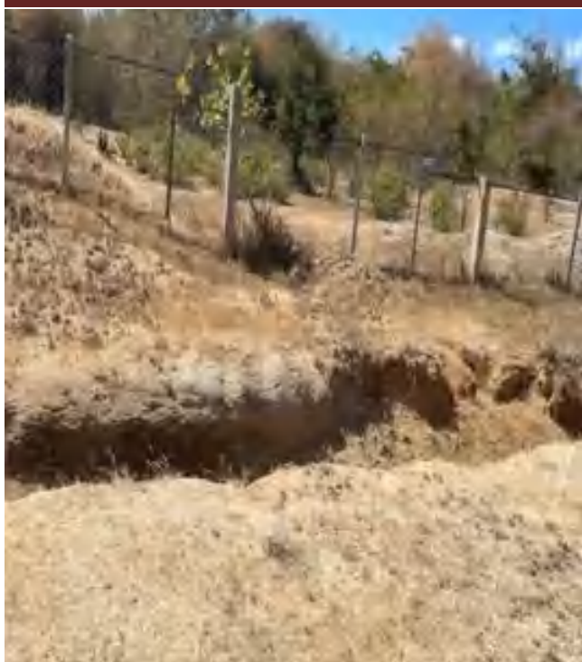
Hình 3.2. Mương thu nước mưa tuyến T1
